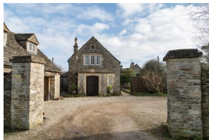
Coppice Cottage, Coppice Lane
